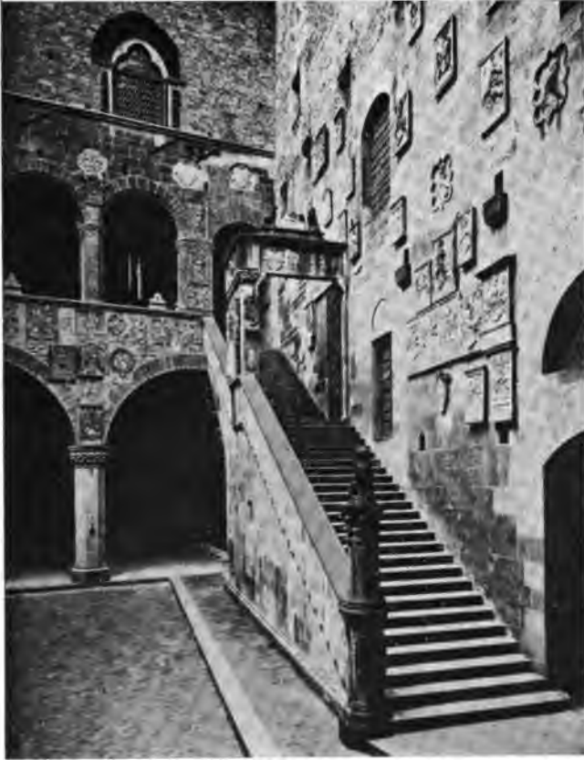
Fig. 95. — Escalier droit dans la cour du Palais de Podestat à Florence : mouvement des marches accusé par les redans de la rampe. Palier défendu par une grille de fer.
